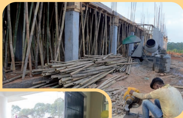
Inizio della costruzione dell'Ospedale di Jowai, ottobre 2018
