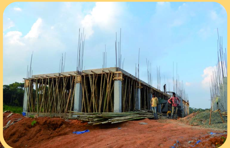
Il cantiere del nuovo ospedale
